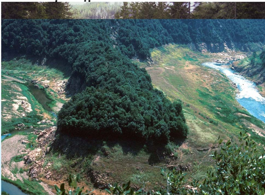
Abb. 2: Kalte Mürz – Restwasserstrecke nach Kraftwerk
